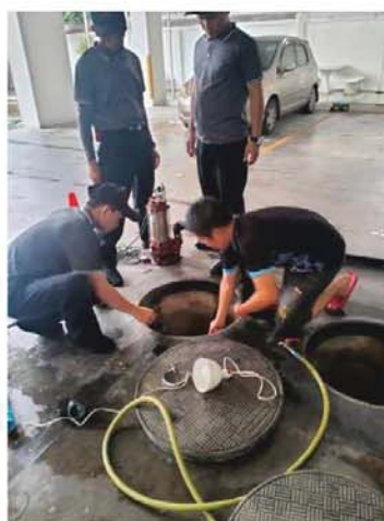
เจ้าหน้าที่ตรวจเช็ค และซ่อมบำรุงระบบบำบัดน้ำเสีย
